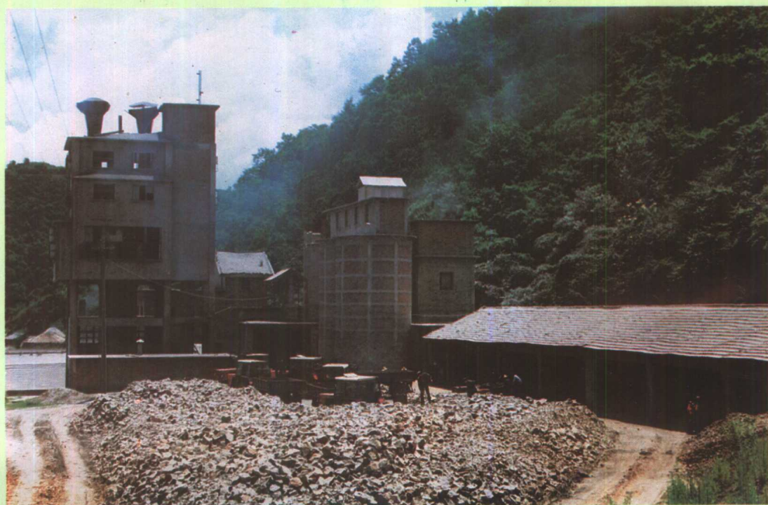
县水泥厂烧结楼
