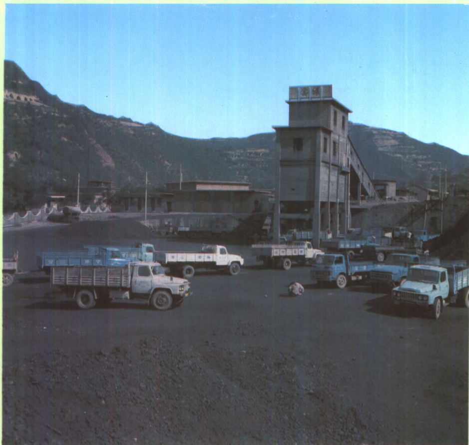
新窑煤矿选煤楼
