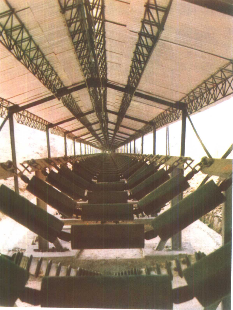
云南小龙潭露天煤矿地面 大型胶带输送机在组装
