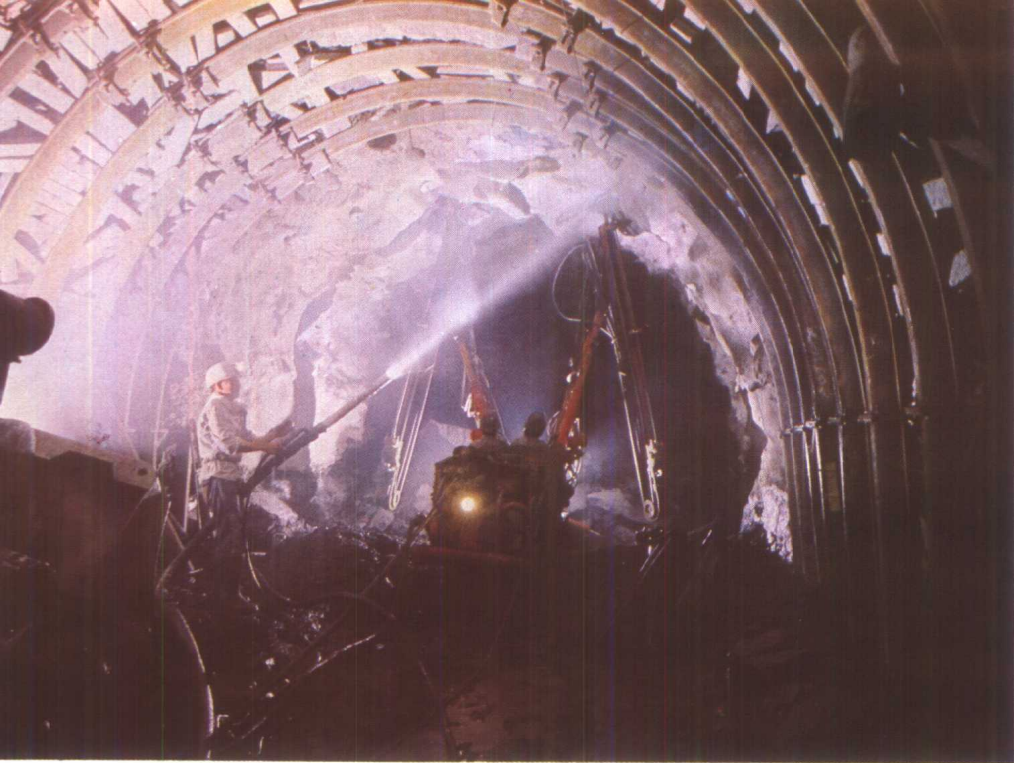
安徽淮南煤炭建设公司 39 工程处在淮南潘集 3 号井的 机械化掘进工作面进行锚喷
