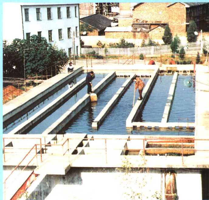
县自来水厂滤水池
