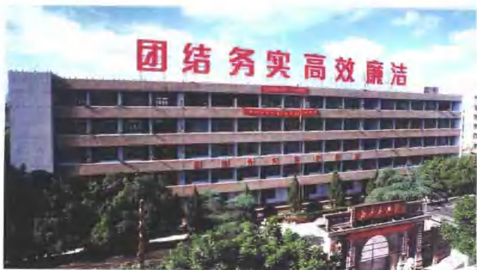
鲤城区政府办公大楼
