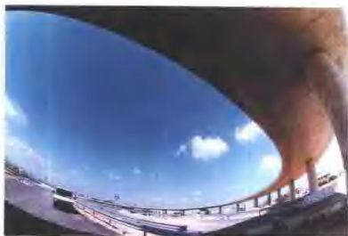
福泉厦高速公路(泉州段)
