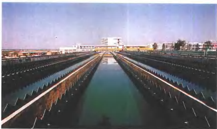
自来水厂滤水池
