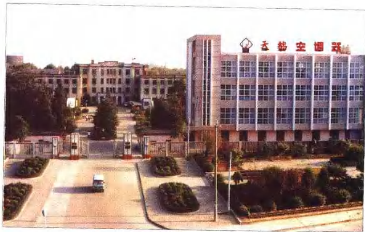
351 厂天鹅空调器测试中心大楼
