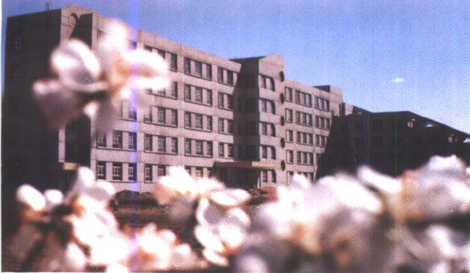
◁ 新建铁岭三中 中教学楼
