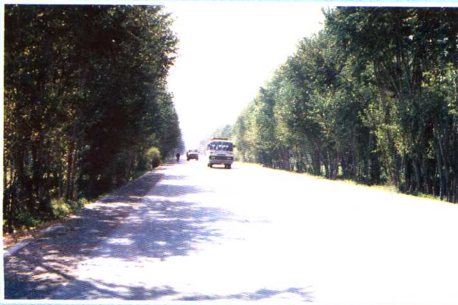
甘青公路林荫道 (109 国道)
