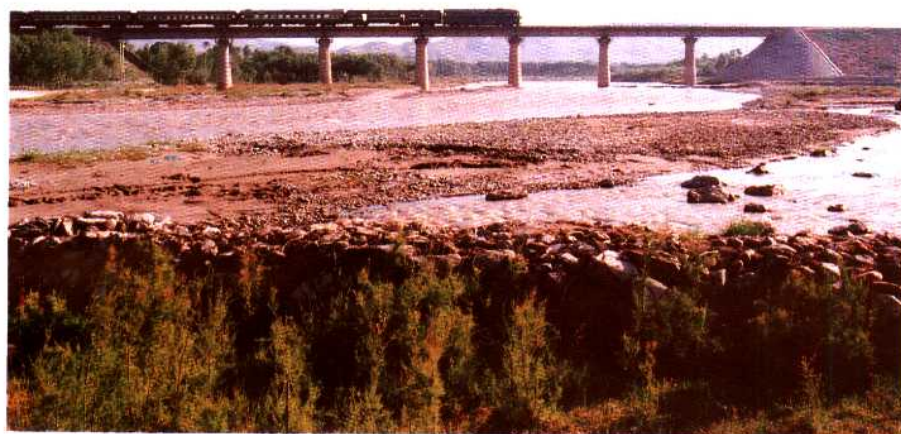
兰青铁路 湟水八号桥
