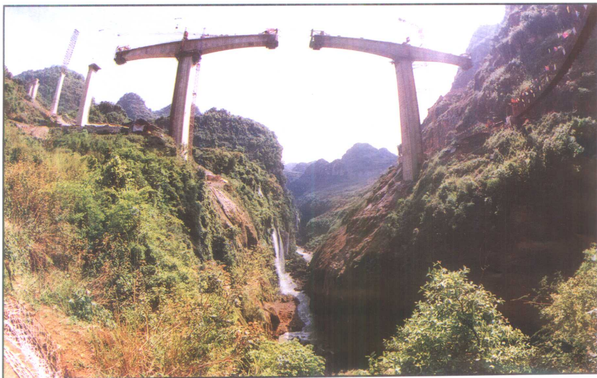
建设中的南昆铁路已进入全面铺开的关键时刻，胜利在望。 ——跨越峡谷的清水河桥是目前亚洲最高的铁路桥。
