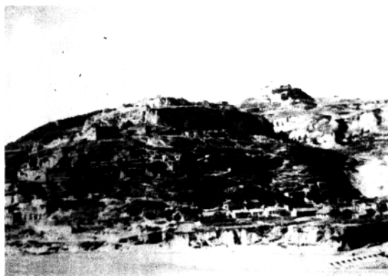
延安气象训 练队住地清凉山 全景(1945年)
