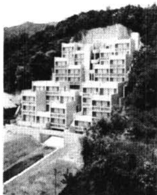
照片2 多摩中央散步路住宅
