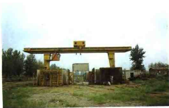
丰台区新兴盒子房屋厂
