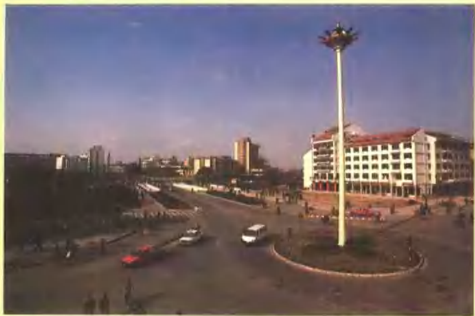
新建成的南门桥工程
