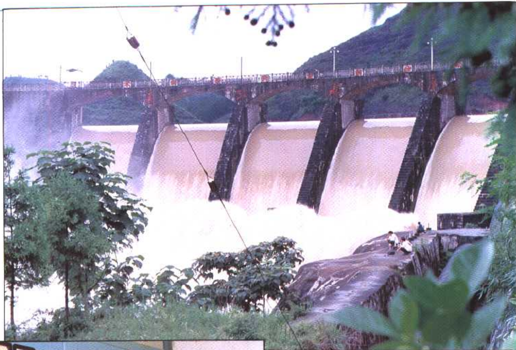
团结水库大坝
