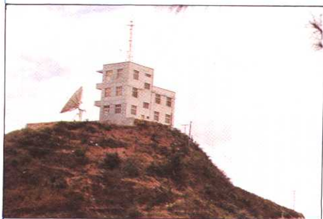
塔坡电视地面卫星接收站
