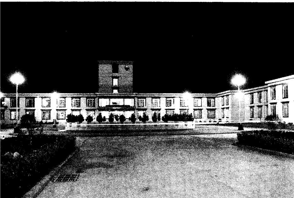
△西藏自治区藏医院住院部
