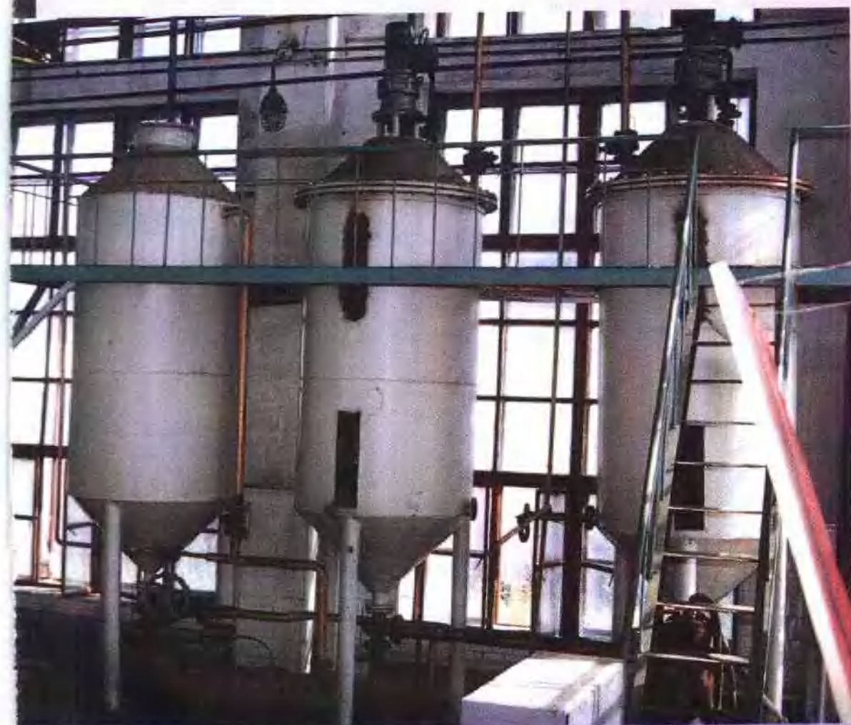
油脂厂浸油车间
