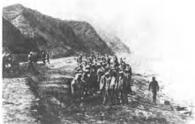
寧蘭公路青銅峽改築工程正在施工
