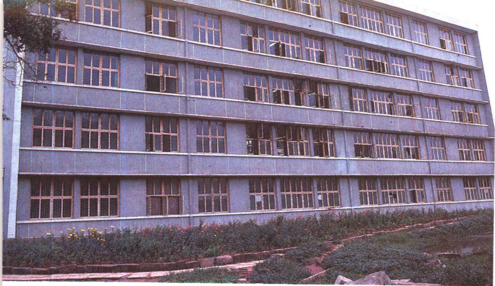
地区教育学院教学大楼
