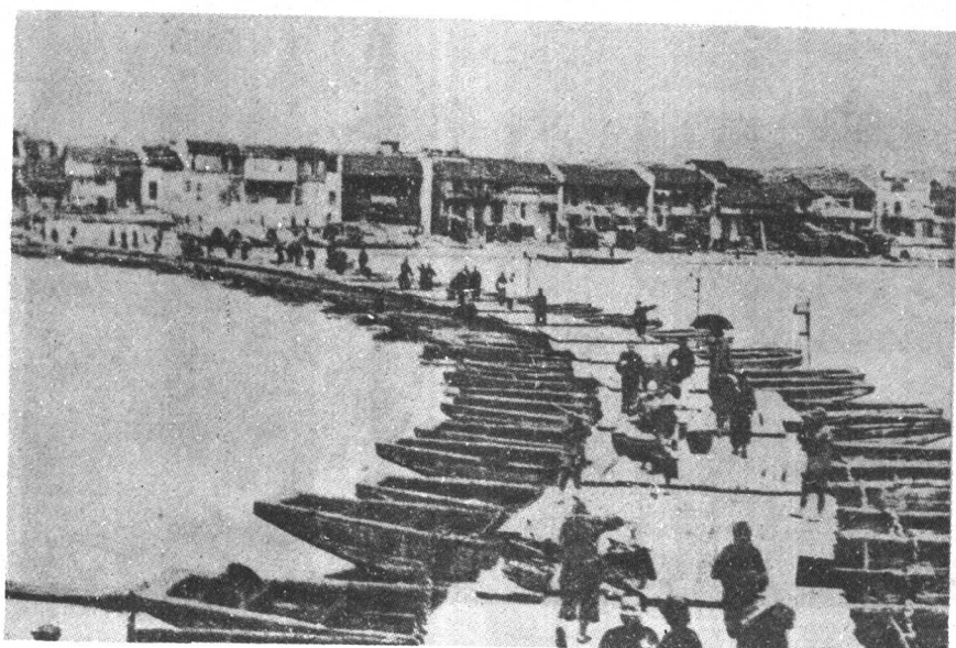
(乙) 广西桂林漓江浮桥
