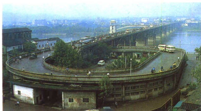
预应力箱型悬墩双曲拱桥——兰江大桥
