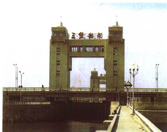
杭州三堡钱塘江运河船闸
