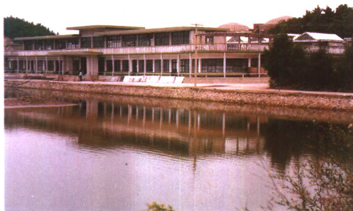
综合性海水水产试验场
