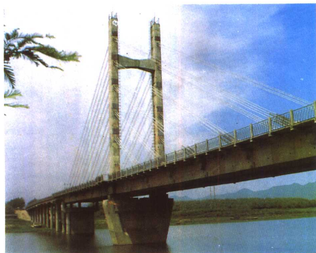
五对斜拉索按竖琴式桥——章镇桥
