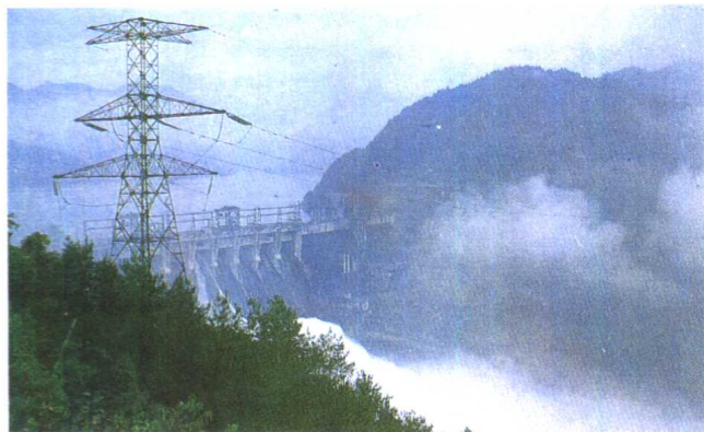
新安江水电站
