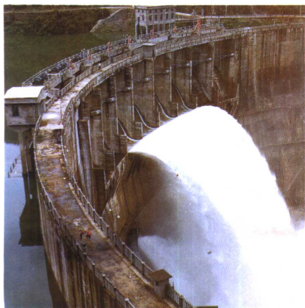
天台县里石门水库拱坝
