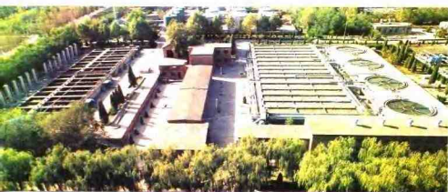
17 污水处理装置一角
