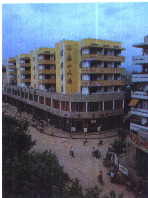
嵊县供销合作社“鹿山大楼”
