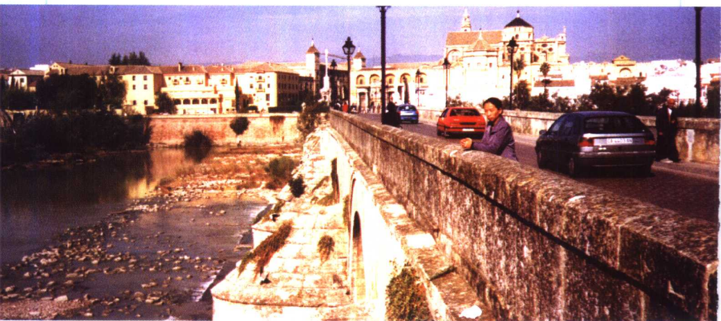
图14 科尔多瓦城瓜达尔基维尔河上的“罗马桥”。在桥的另一头，La Mezquita的昔日宣礼塔依稀可见；桥的这一头即“三文化展览”所在的塔楼
