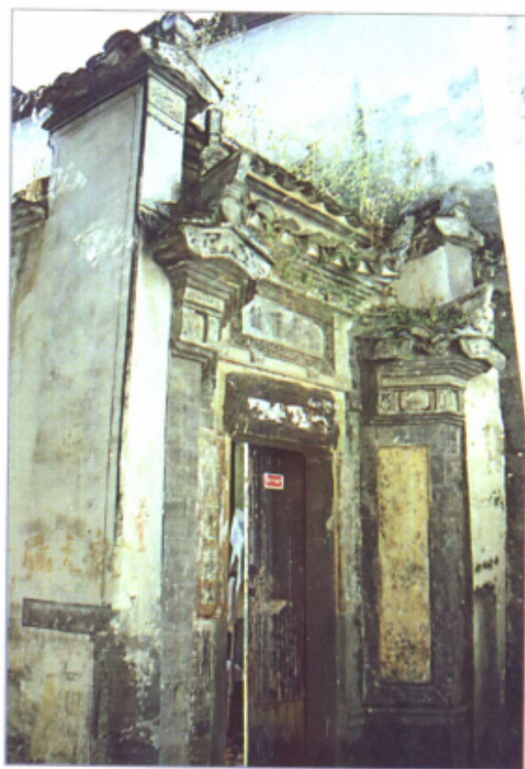
皖南古民居门楼
