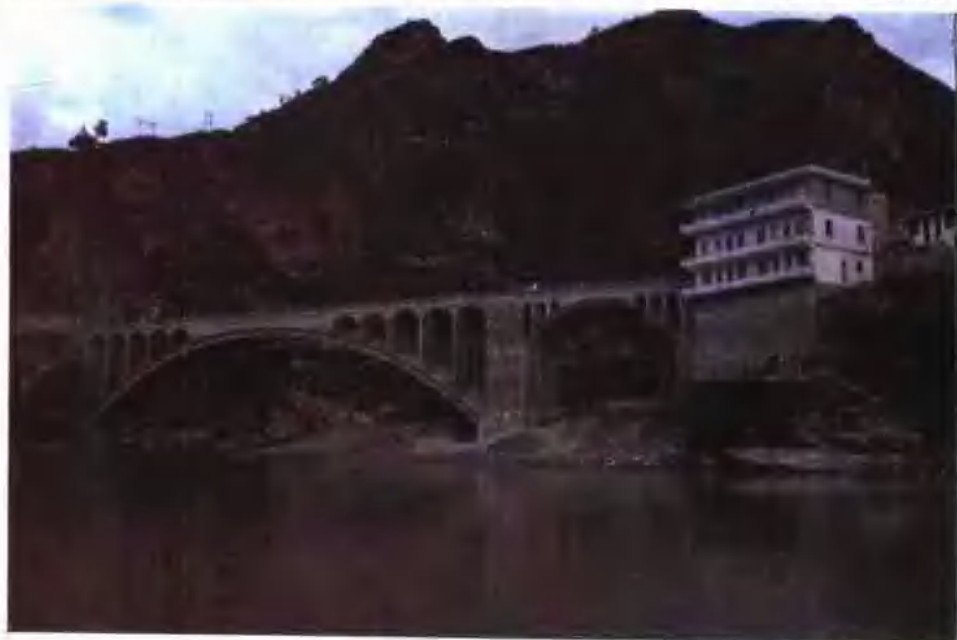
旬(阳)白(河)公路冷 水河大桥
