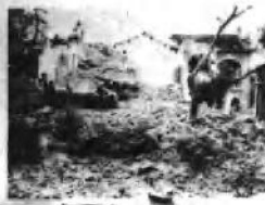
第三圖：集大第一校門前之石橋，被敵飛機炸毀，橋面全斷，橋墩亦受炸彈之擊，橋上之石欄亦被炸毀，橋上之石欄亦被炸毀。
