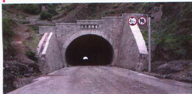
大纳公路山王庙隧道道口
