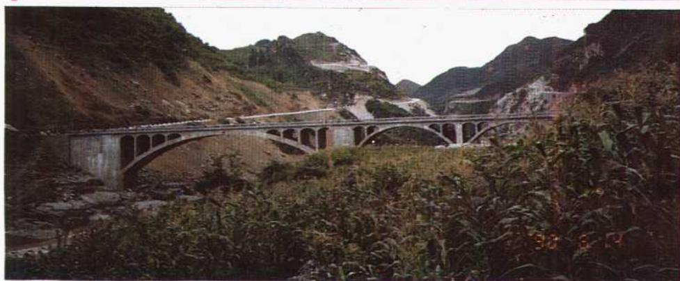
织金县 天龙一小黄 河公路上的 斯拉河大桥
