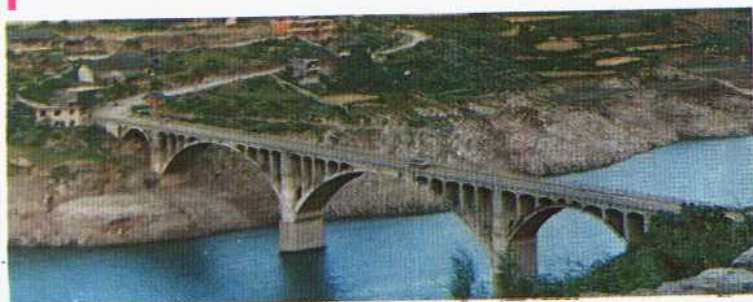
三杨公路沙三大桥
