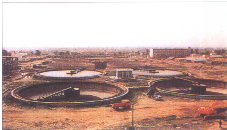
施工中的污水处理厂
