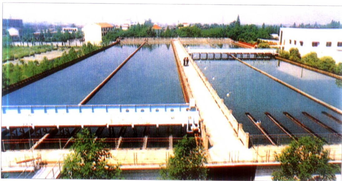
祥符自来水厂平流式沉淀池
