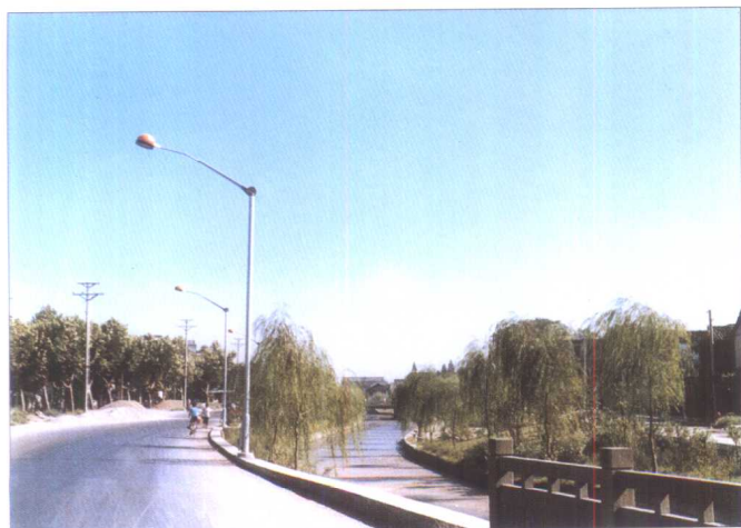
在建的中河路南段
