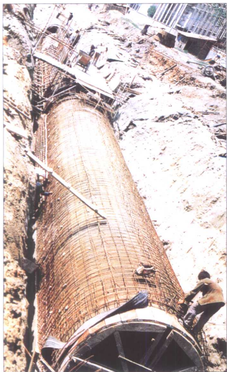
施工中的雨水暗渠
