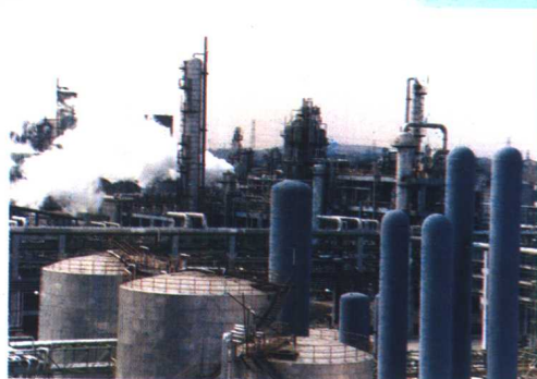
图为化工生产区一角
