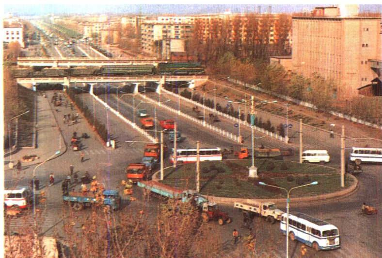
▲ 解放路立交桥
