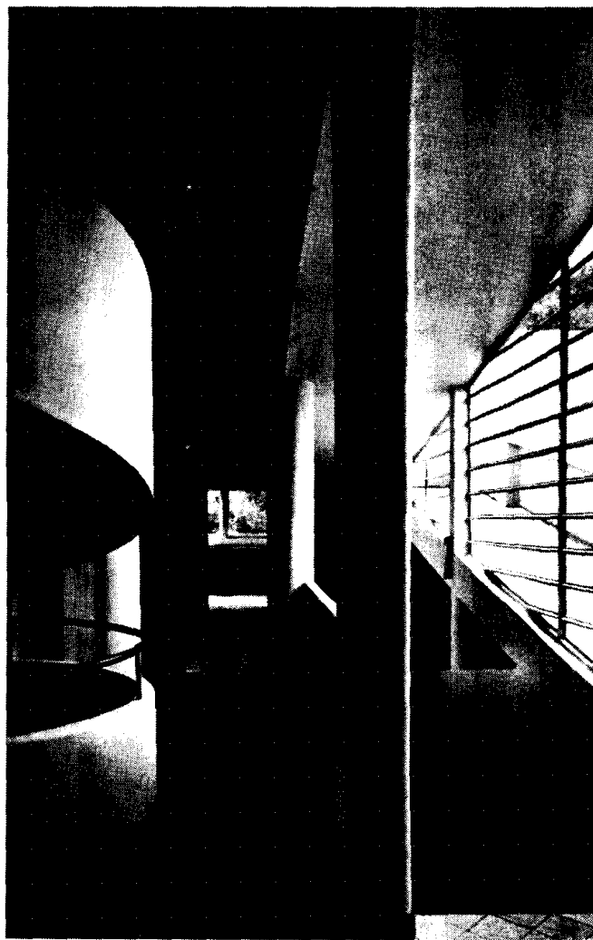
底层坡道与螺旋楼梯的构图组合
