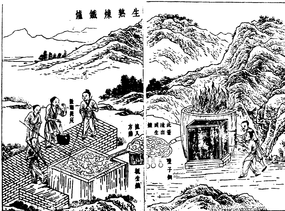
图八 《天工开物》生熟炼铁炉图
