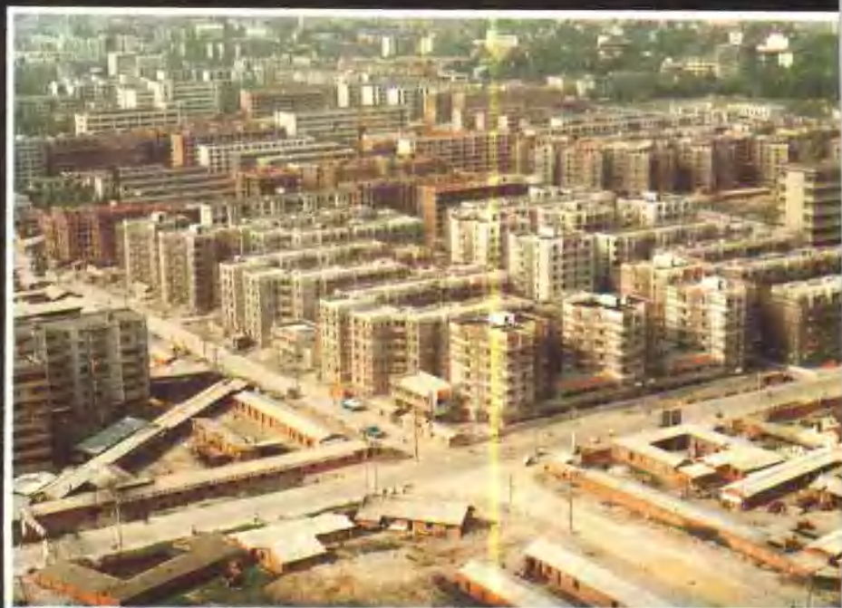
► 在建设中的棕白小区
