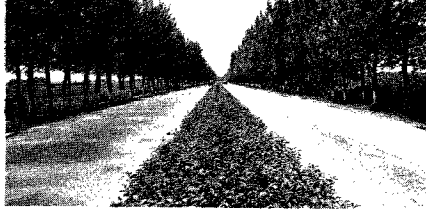
淮阴—沐阳一级公路
