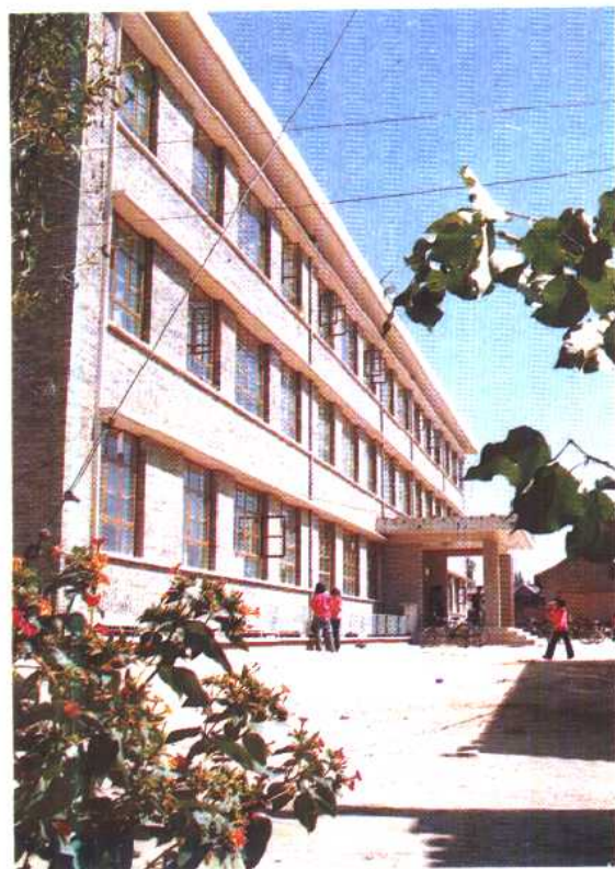
← 寿阳中学教学楼
