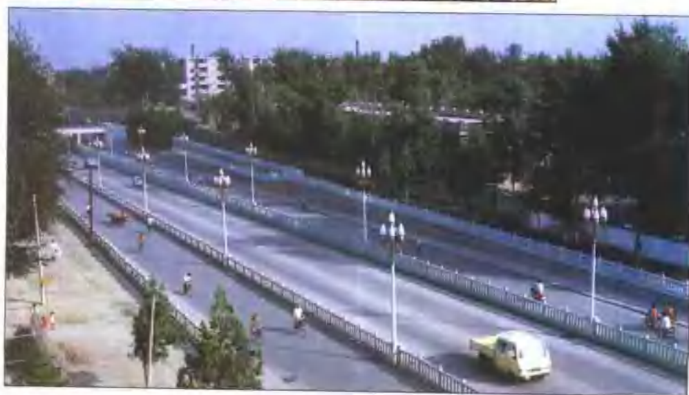
东风路地道桥
