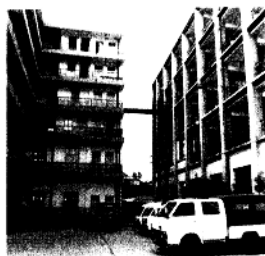
◇ 公司辦公大樓一角
