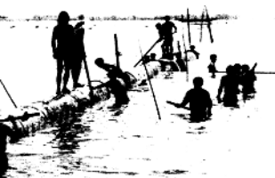
○管道修建工为用户排忧解难
