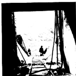
○建设中的松花坝高位引水隧道
