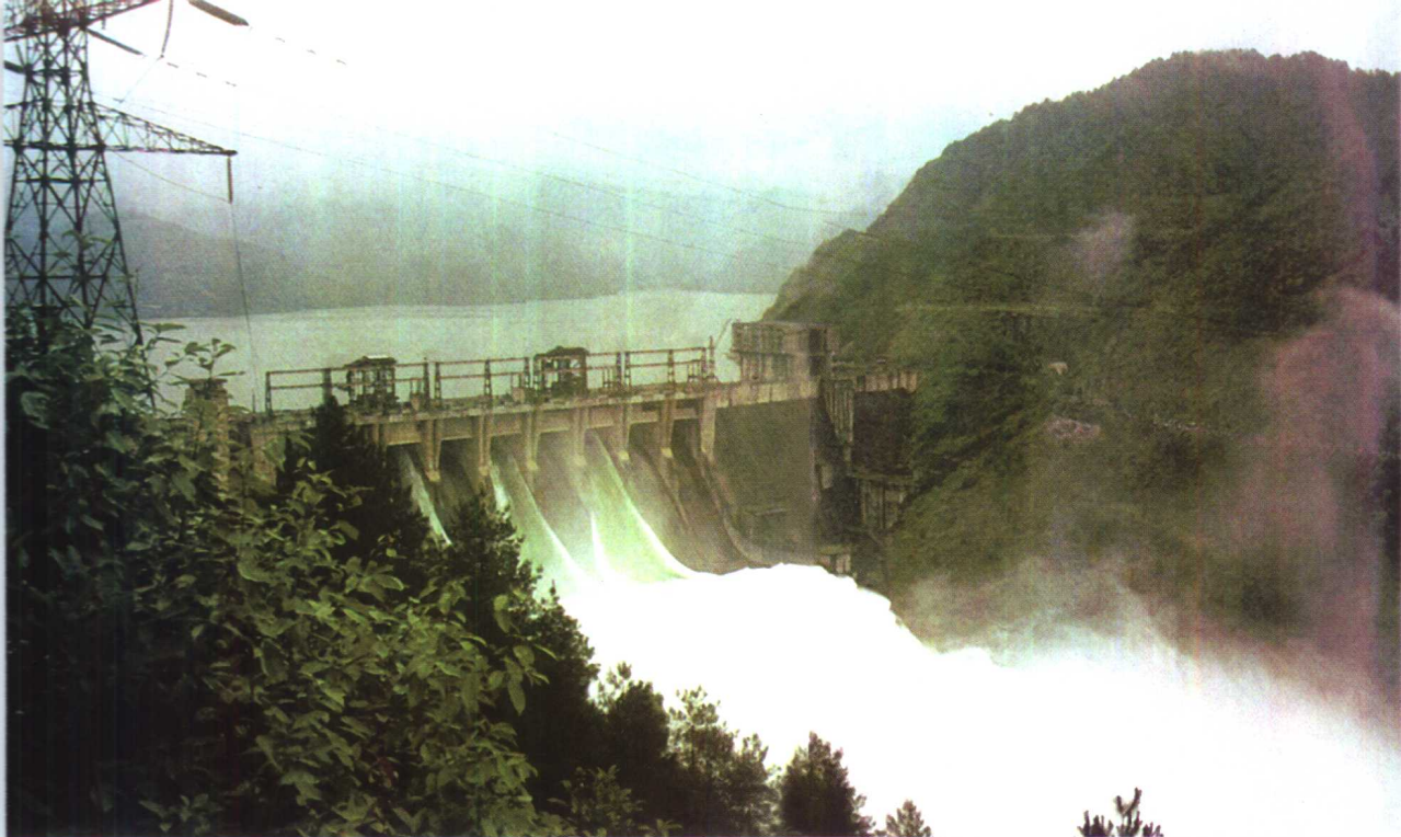
新安江水电站
