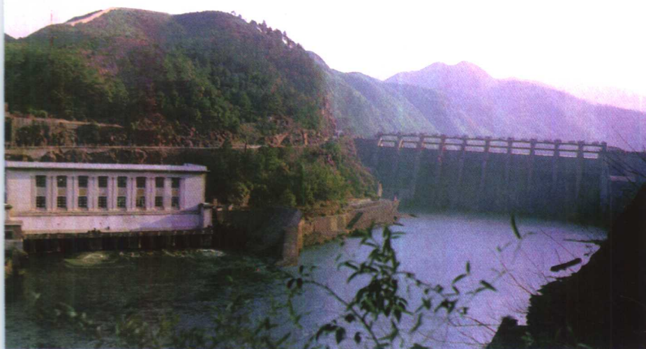
黄坛口水电站
