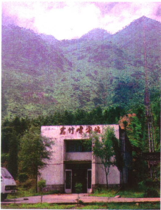
临海岩竹峰水电站（水头484米）
