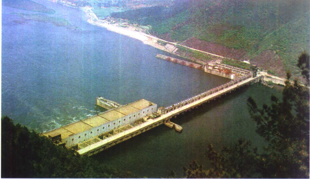
富春江水电站
