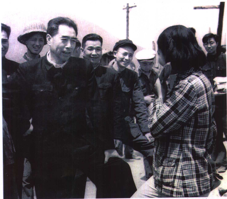
周恩来在新安江水电站工地与工人亲切交谈（1959）
