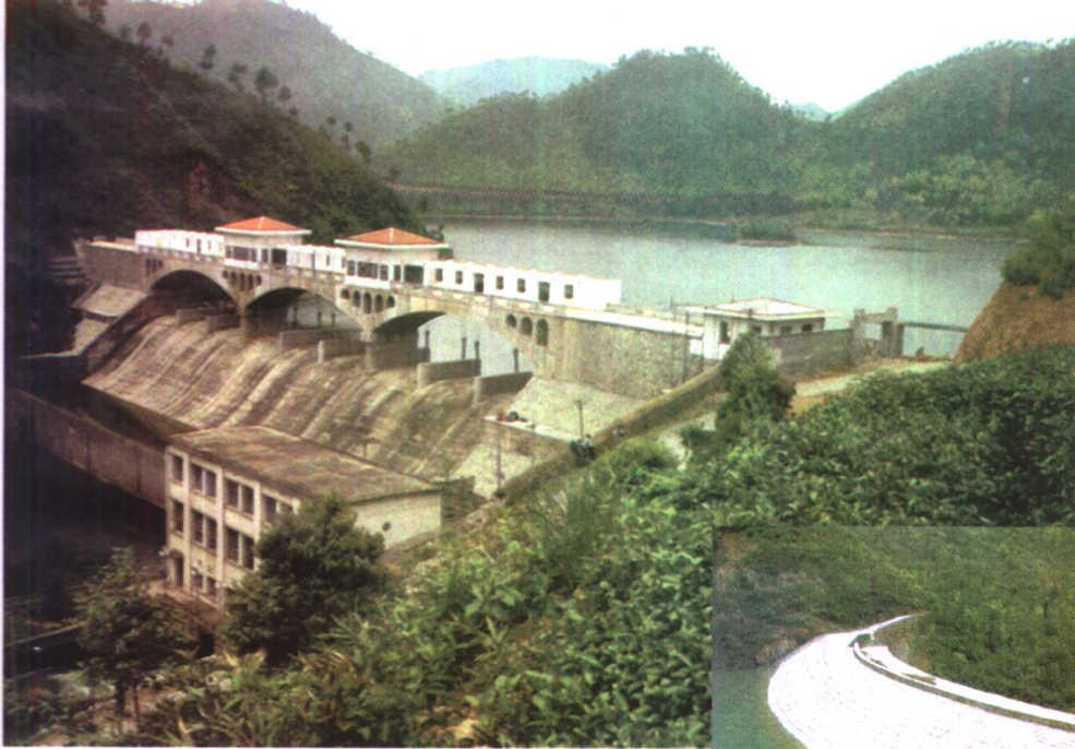
富阳岩石岭水库
