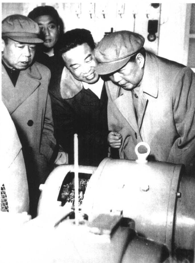
毛泽东视察金华 双龙水电站（1960）
