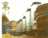
总投资 10 亿元的平坝 宏大铝化工公司施工现场
