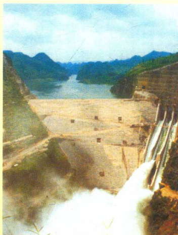
县境内的36万千瓦引子渡水电站
