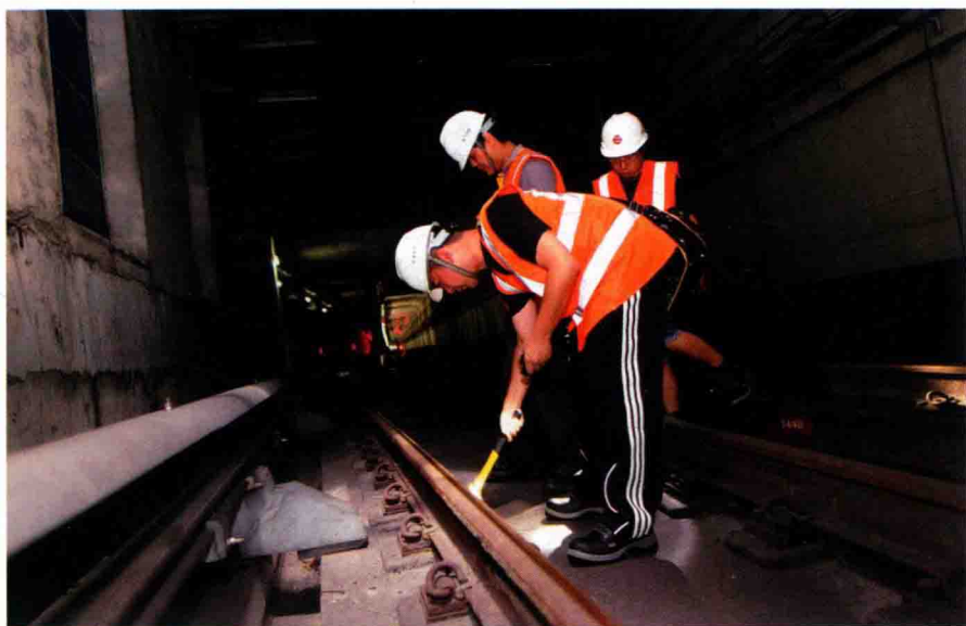
◆ 2012年5月27日凌晨，地铁大兴线黄村西大街站隧道，记者汤旸（前）体验地铁巡道员的工作。
