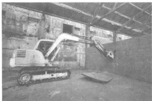
图 1.6 沈阳市奉天记忆文创园再生利用项目 (破碎机拆除施工)
