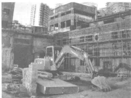
图 1.7 上海市红坊文创园再生利用项目 (挖掘机拆除施工)
