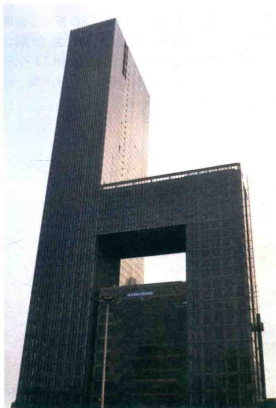
■ 武汉保利文化广场 221 m 高钢结构写字楼，采用 62 个黏滞阻尼器，改善风荷载下的舒适度，提高结构的抗震性能。
