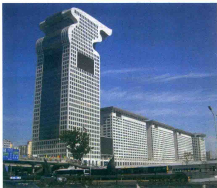
■ 北京盘古大观广场 毗邻奥运场馆鸟巢的 40 层、192.5 m 高的超高层钢建筑。为满足规范对抗风、抗震的要求，采用 108 个液体黏滞阻尼器耗能减震方案，不仅大大增强结构整体抗震能力，提高安全储备，而且其经济性能优越。
