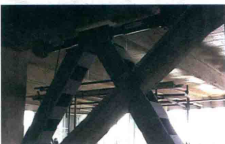
■ 北京盘古大观广场 毗邻奥运场馆鸟巢的 40 层、192.5 m 高的超高层钢建筑。为满足规范对抗风、抗震的要求，采用 108 个液体黏滞阻尼器耗能减震方案，不仅大大增强结构整体抗震能力，提高安全储备，而且其经济性能优越。
