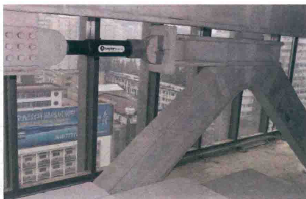
■ 天津国际贸易中心 256 m 高钢结构，共 60 层。国内首次在高层钢结构建筑中采用套索形式连接阻尼器，在结构加强层上共安装 12 套液体黏滞阻尼器，使结构满足抗风要求，同时增强抗震能力。
