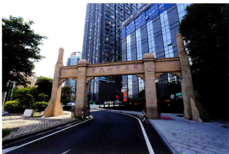
西门石牌坊（正面）
