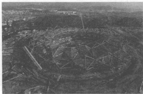
图 1-5 施工中的建筑
