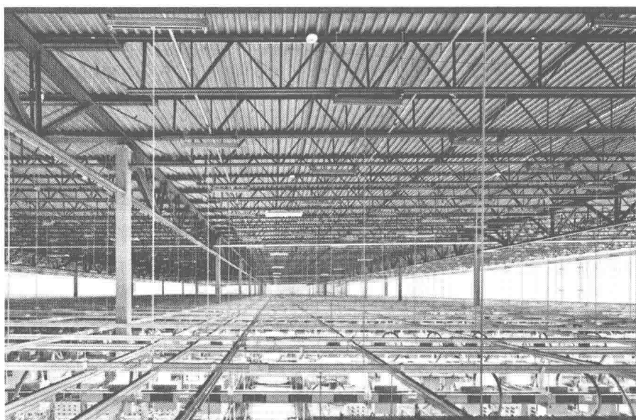
图 1.1 谷歌公司数据中心
