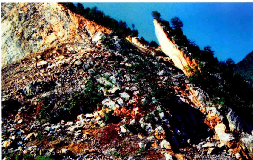
崩塌后，残留在北侧变电房山顶的危岩
