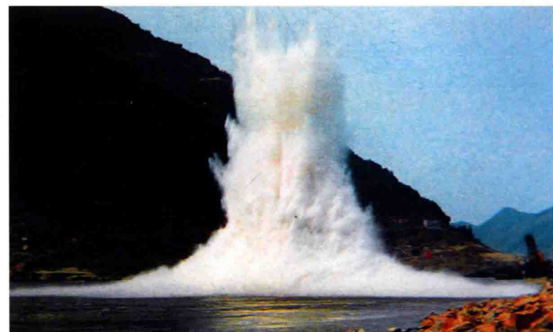
江中水下爆破清理滑坡入江土石形成的滩体
