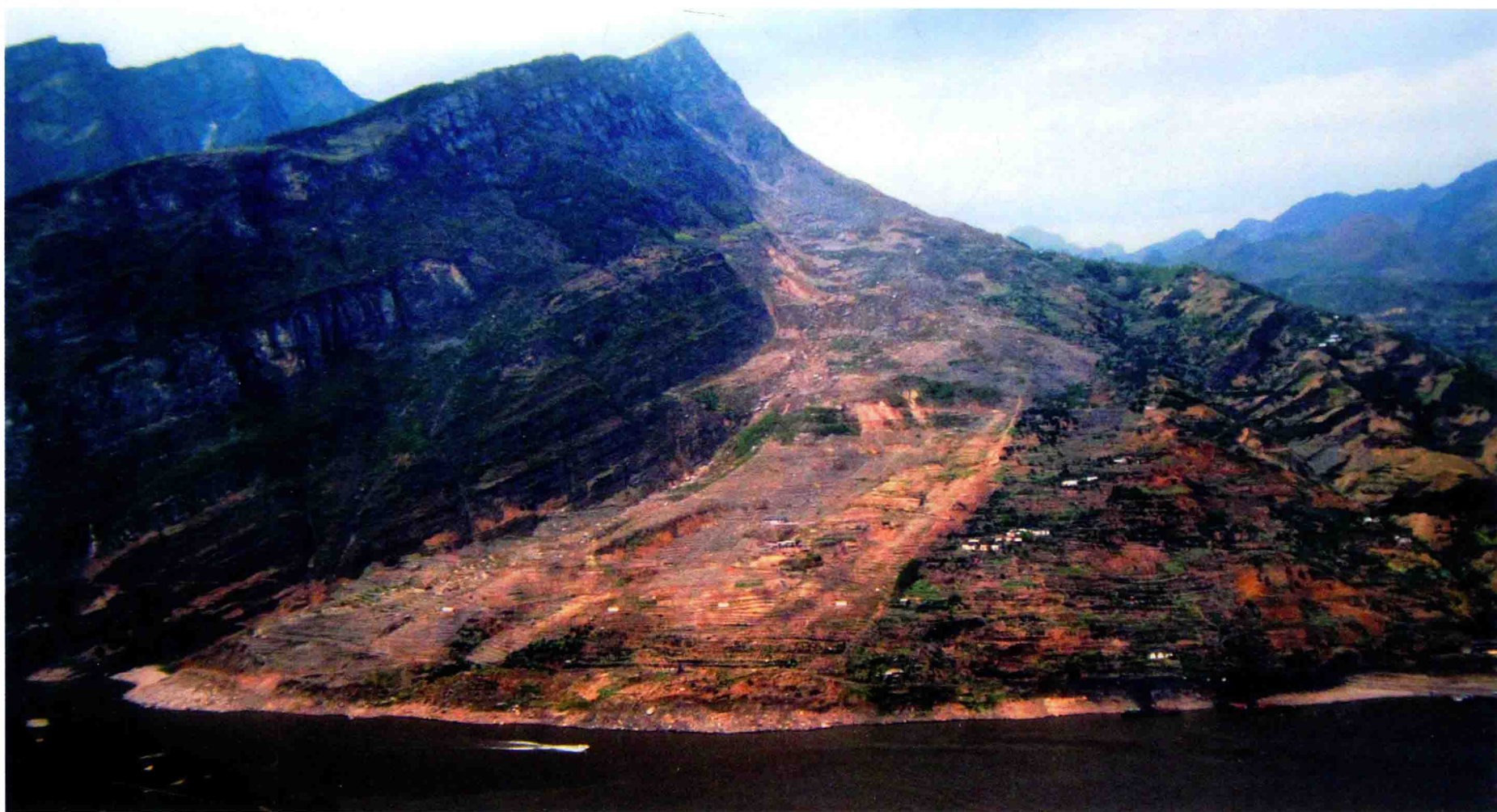
秭归县新滩滑坡全貌
