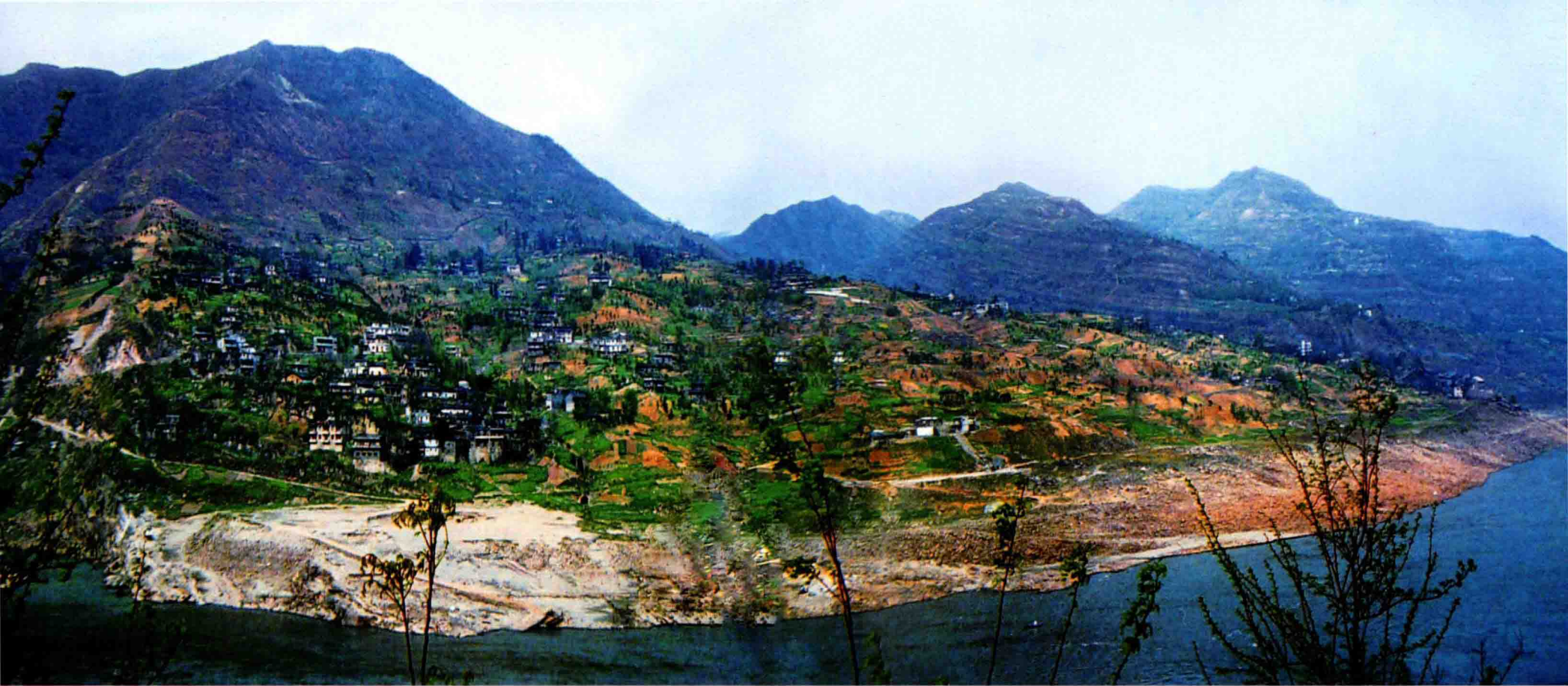
云阳县鸡扒子滑坡全貌
