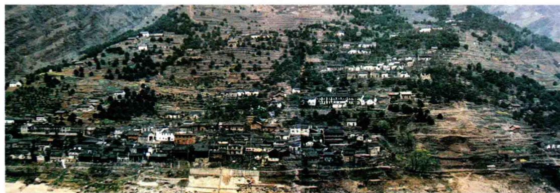
滑坡前的新滩古镇
