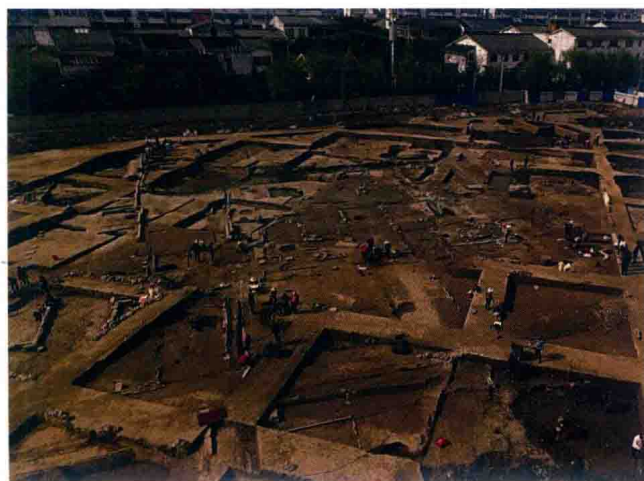
图四 西区发掘场景
