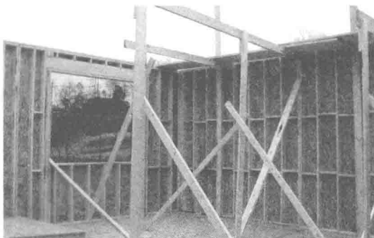
(b) 施工中的墙体
