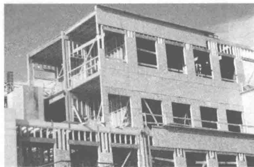
(b) 建造中的多层轻木结构住宅
