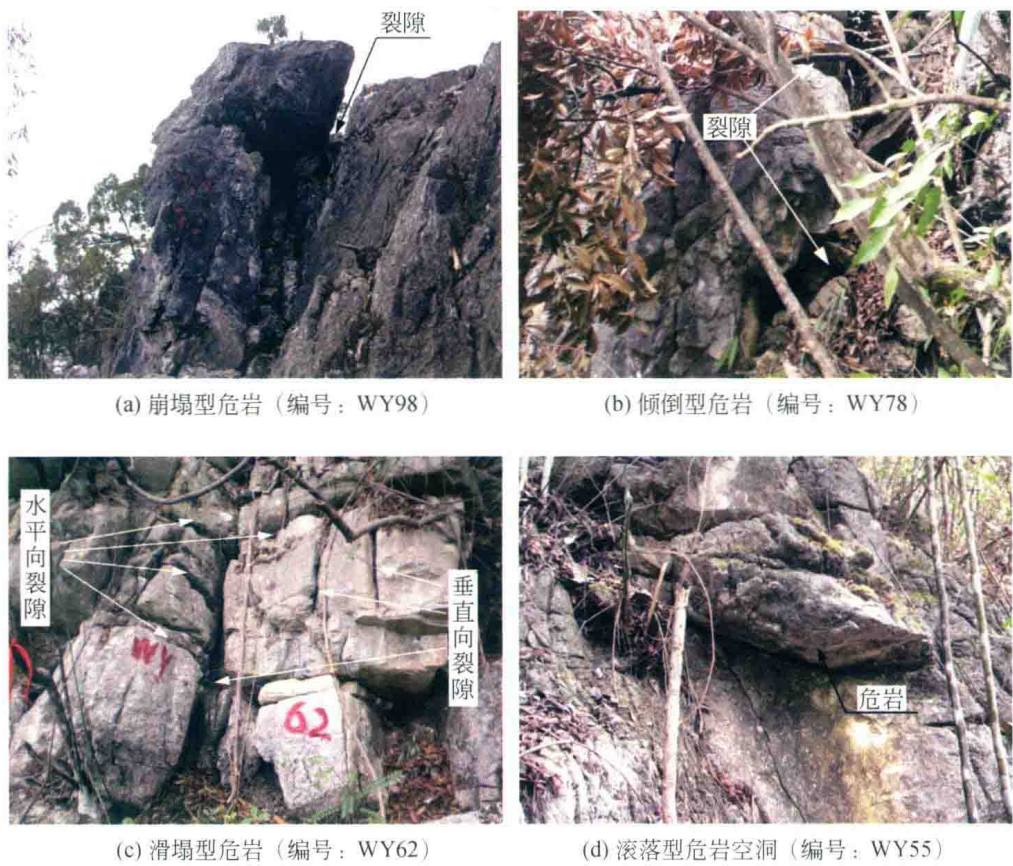
图 0.2 FAST 台址不稳定斜坡危岩体现场照片
