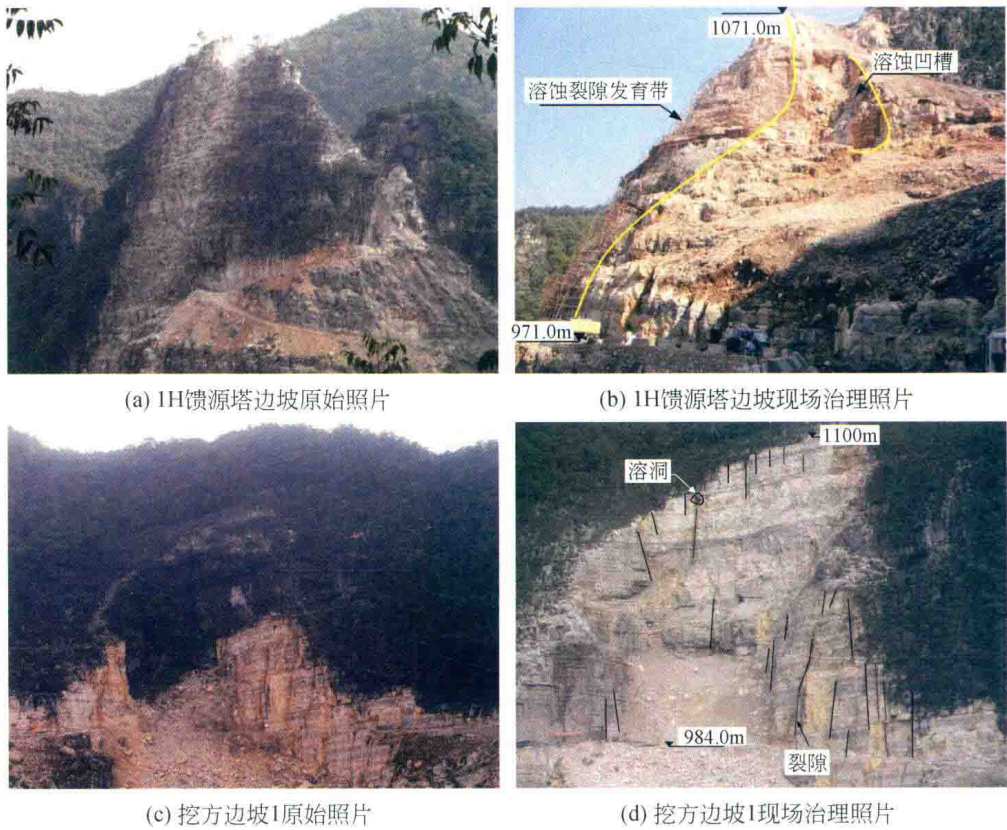
图 0.5 FAST 台址超高边坡现场照片图
