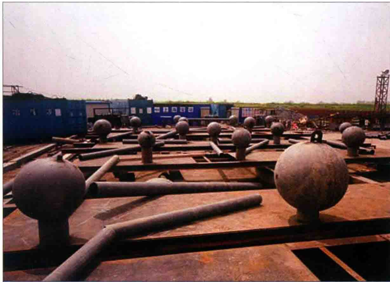
图10 焊接球的拼装
