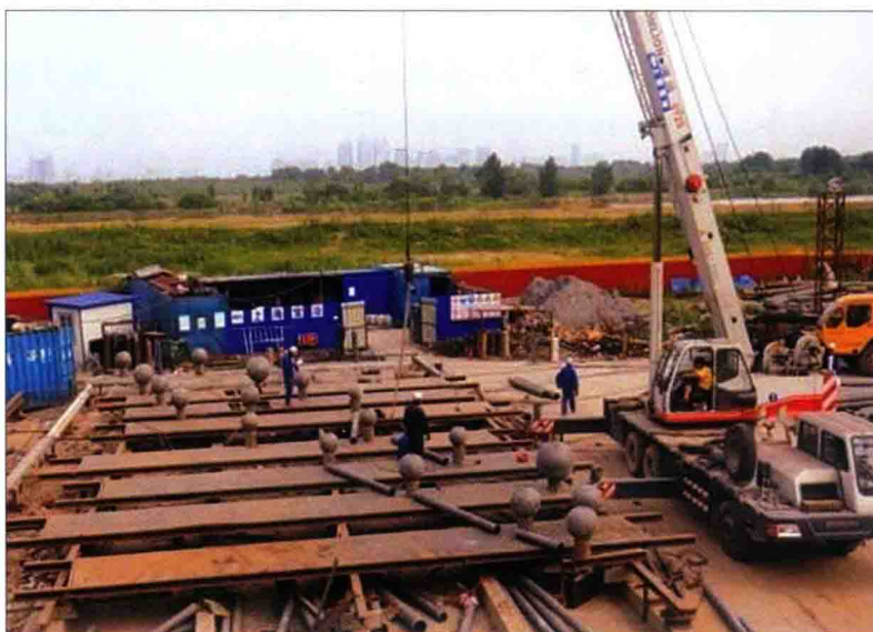
图 11 球间杆件的安装
