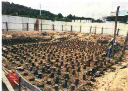
检查松木桩数量、间距、压桩深度
