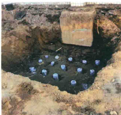
检查混凝土桩数量、间距、压入深度
