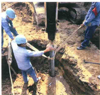
检查混凝土桩规格、尺寸、质量
