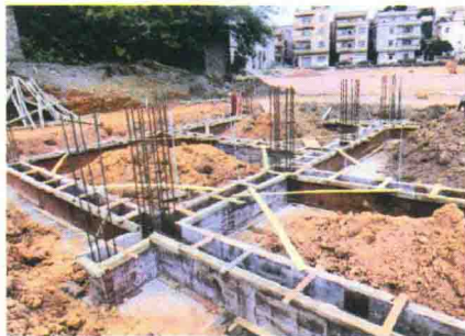
检查地梁钢筋规格、数量、尺寸、间距、搭接或焊接长度、锚固长度、箍筋弯钩等
