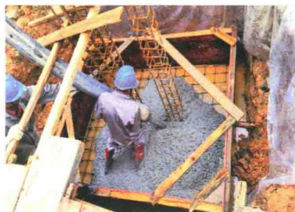
检查浇筑顺序、自由下落高度
