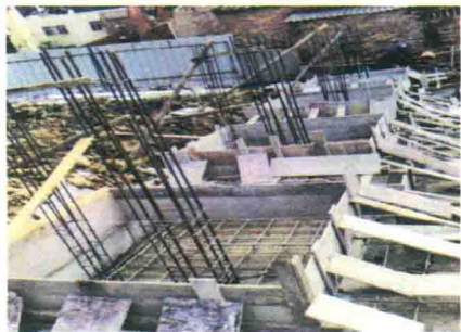
检查基础承台钢筋规格、数量、尺寸、间距、锚固长度、箍筋弯钩等
