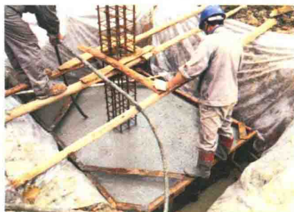
检查振捣次数、振点间距, 防止碰撞钢筋、模板、预埋件; 浇筑完成后, 复核基础尺寸和钢筋偏移量
