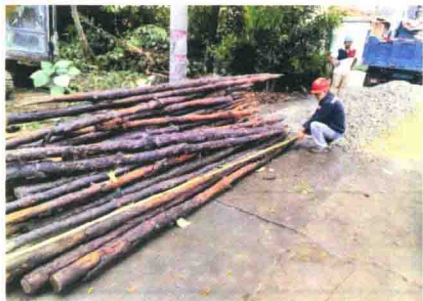
检查松木桩规格、尺寸、质量
